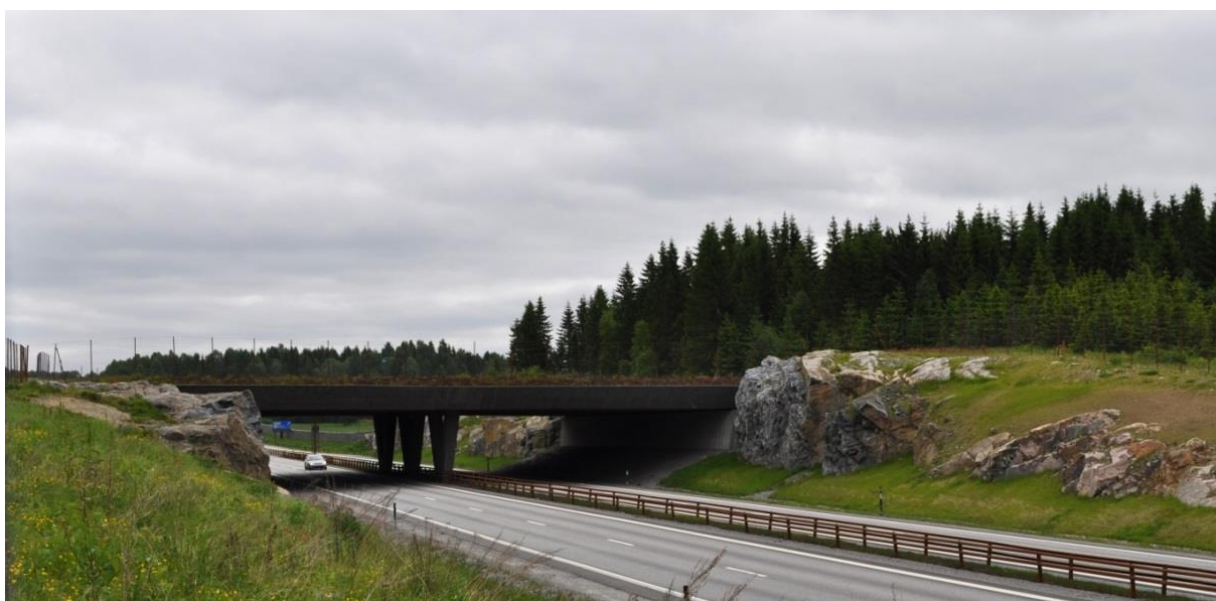
Figur 1.12. Bogsrud overgang. Foto. Ole Roer
