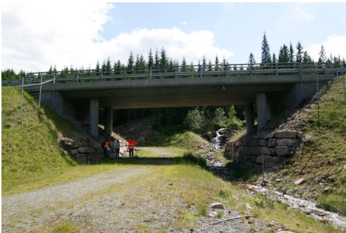
Figur 1.22. Sørlivegen undergang. Foto. Mathilde H. Skarsjø
