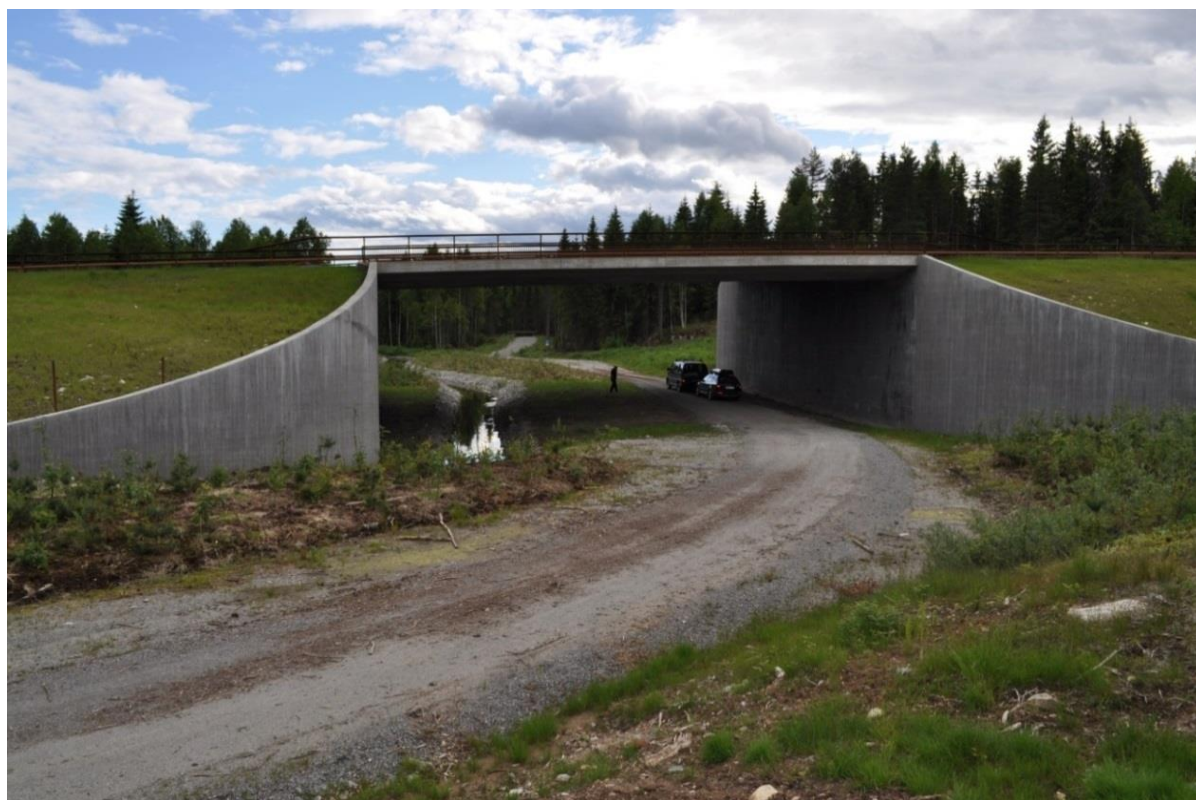
Figur 1.7. Grevlingmyra undergang. Foto. Ole Roer
