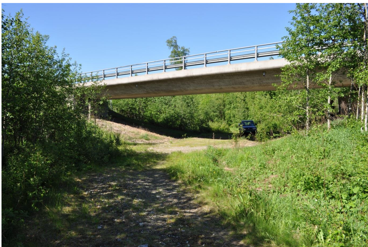
Figur 1.18 Bjørkåsen undergang. Foto. Ole Roer
