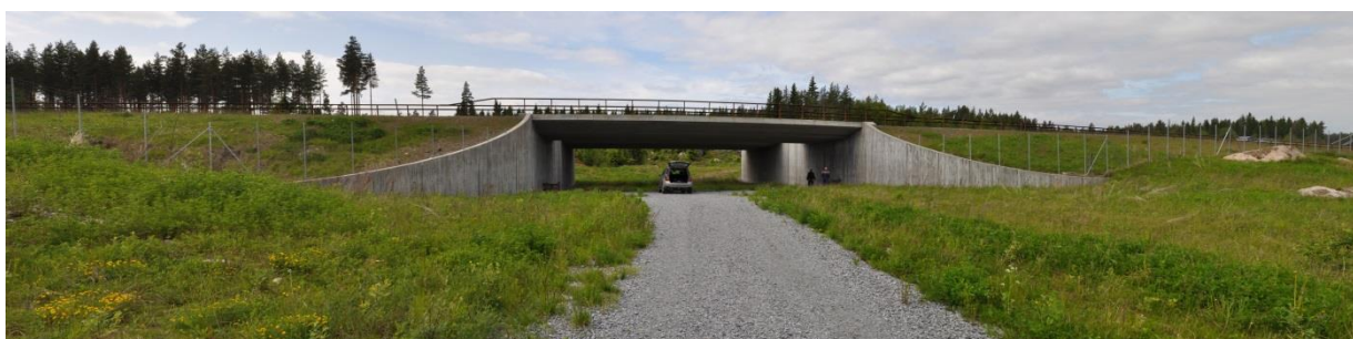
Figur 1.17 Sørli undergang. Foto. Ole Roer
