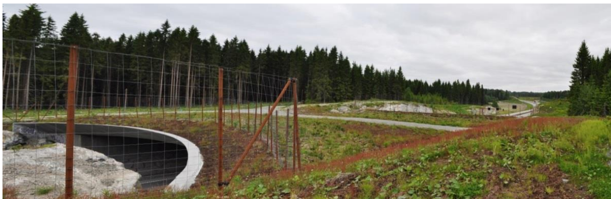
Figur 1.11. Bogsrud overgang. Foto. Ole Roer
