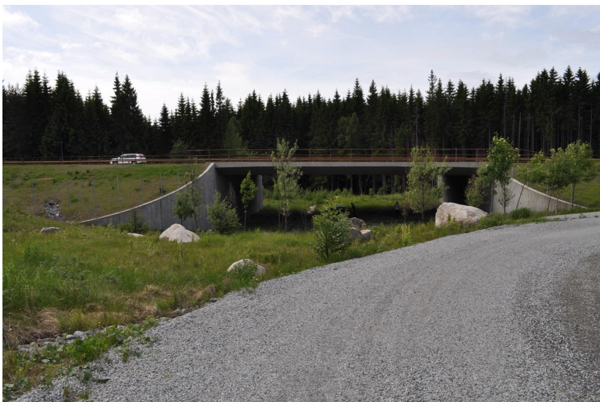
Figur 1.13. Hov undergang. Foto. Ole Roer
