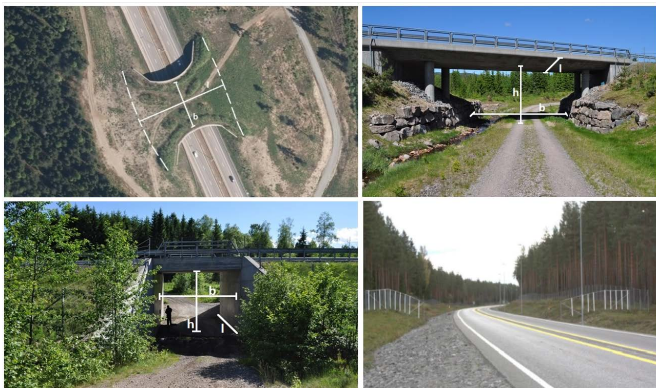
Figur 2.1.1. Illustrasjon av overgang (oppe til venstre), undergang (oppe til høyre), kulvert (nede til venstre) og viltsluse (nede til høyre). Foto: Ole Roer og Skoenen m.fl. (2011).
