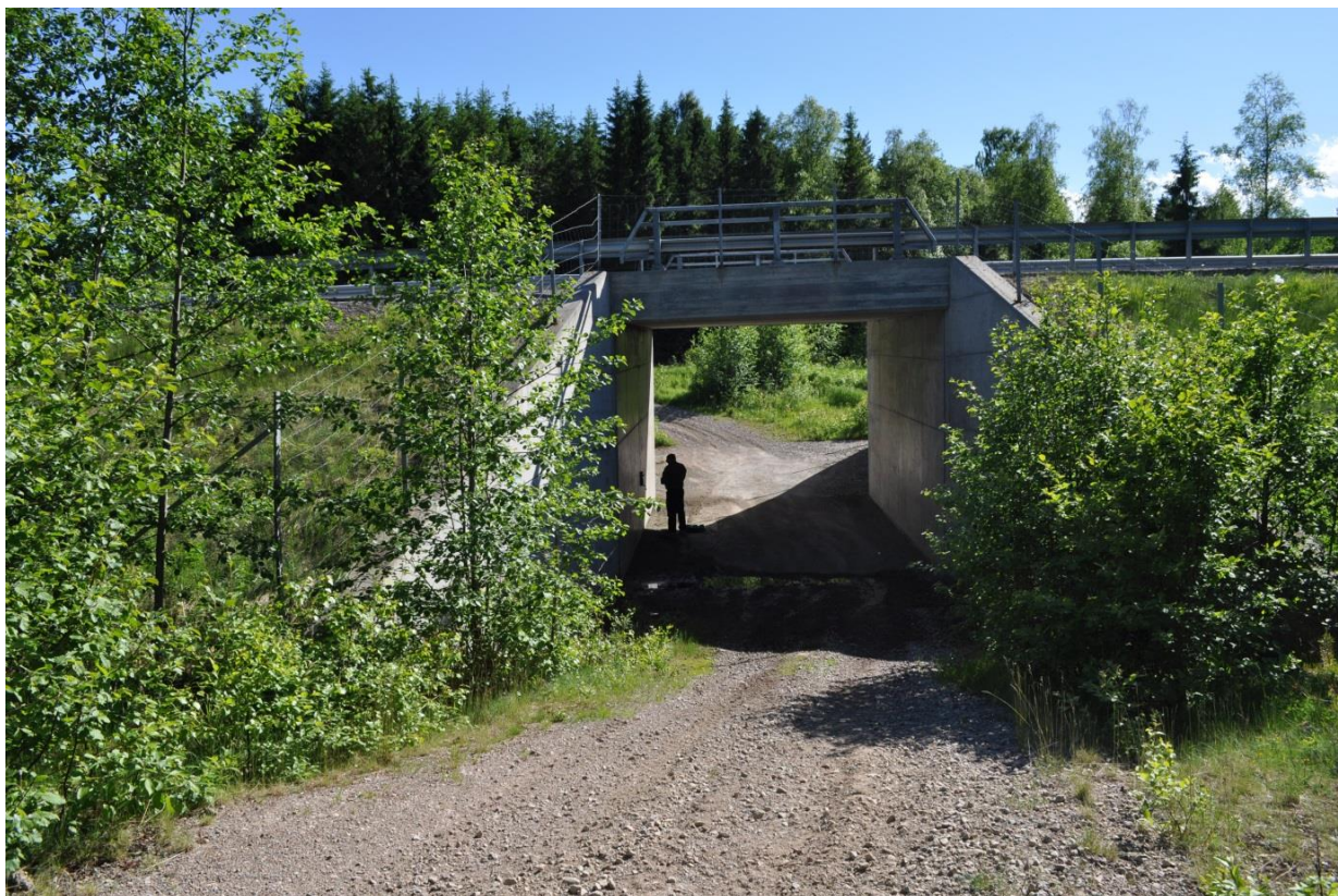
Figur 1.19. Bråtebekken kulvert. Foto. Ole Roer
